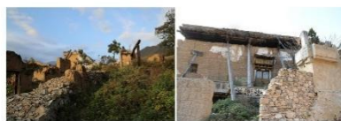
图0-2 震后的残垣断壁
