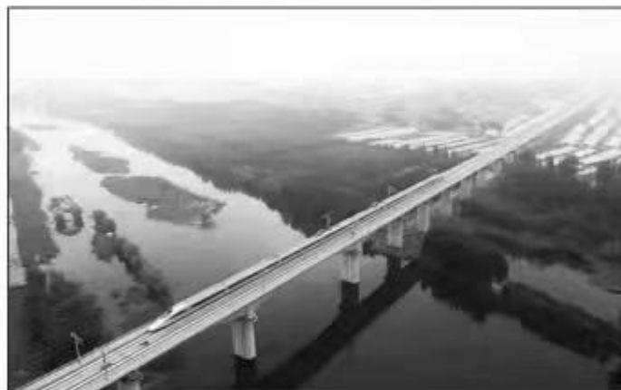
8月10日, CRH380A型高速综合检测列车以200公里的时速从济南高铁东光段过黄河大桥呼啸而过,这列被称为黄医生号的动车组将对济青高铁的设计速度、通信及信号系统、客运服务系统等17大项内容进行全面测试。
